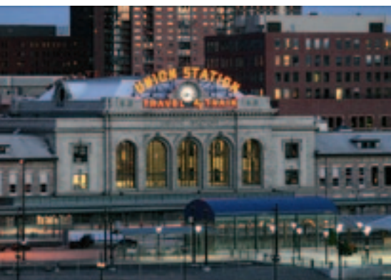
Рис. 4. Вокзал Юнион в Денвере (на среднем плане — станция общественного транспорта)
