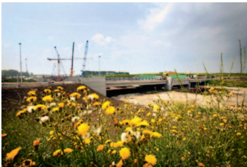
Рис. 1. Строительная площадка тоннеля Oude Maas на линии HSL-Zuid (фото: HSL-Zuid)
