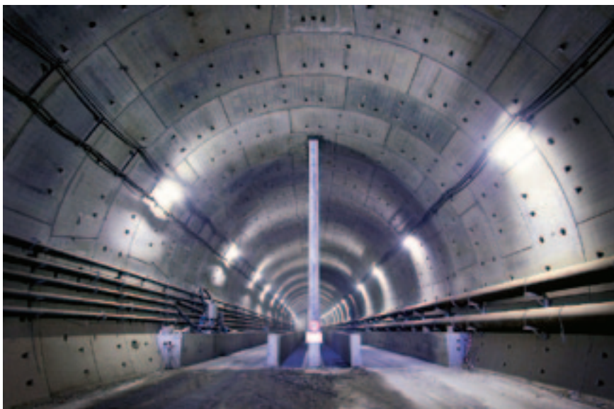
Рис. 2. Строительство тоннеля Groene Hart на линии HSL-Zuid (фото: HSL-Zuid)
