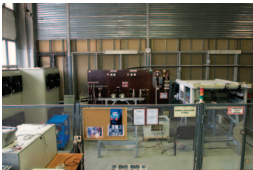
Рис. 4. Общий вид испытательного стенда
