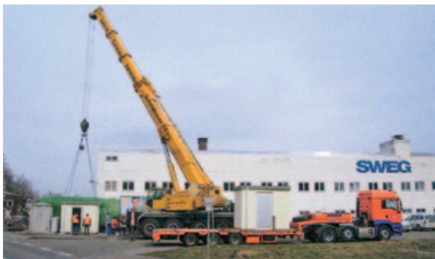
Рис. 8. Монтаж бетонного киоска с аппаратурой системы Sicas S7
