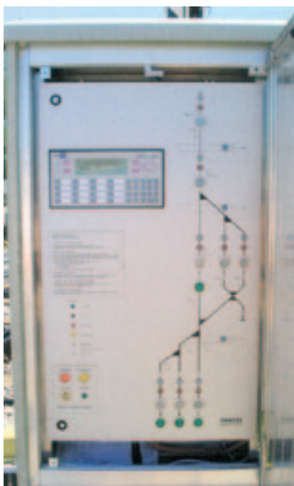
Рис. 6. Напольное табло установки маршрутов
