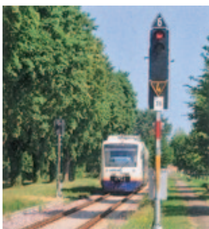
Рис. 3. Основной сигнал на железной дороге Kaiserstuhlbahn
