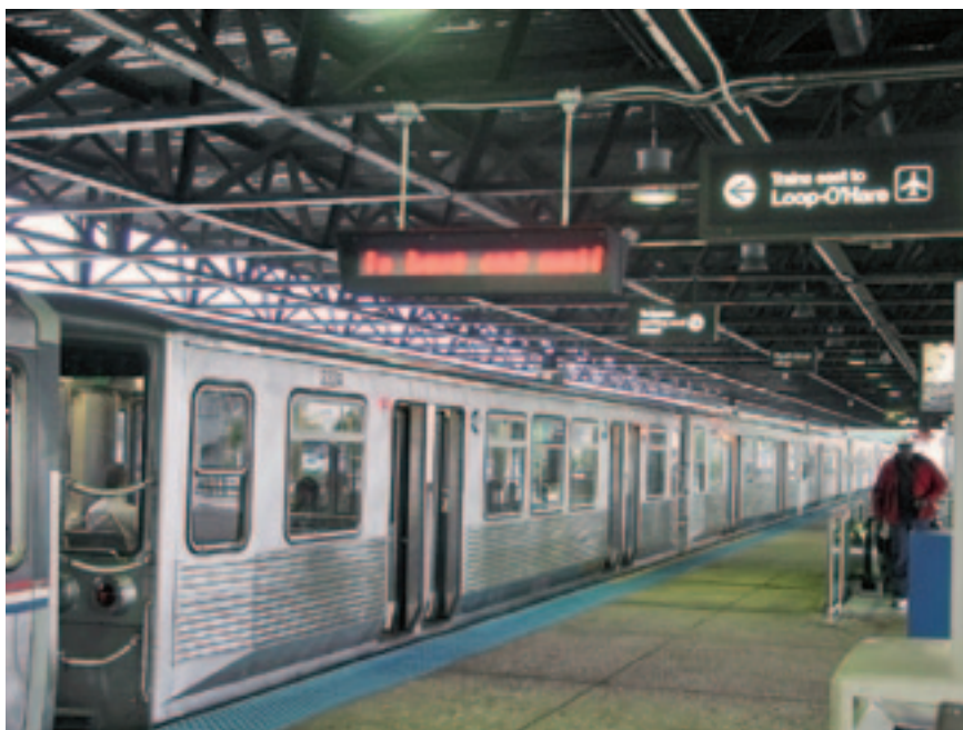
Рис. 3. Станция СТА в аэропорту О'Хара
