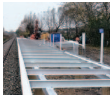
Рис. 2. Общий вид несущей рамы
