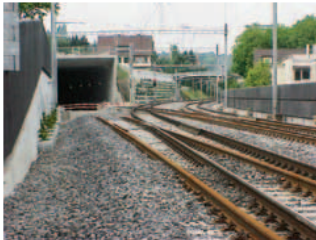
Рис. 2. Портал тоннеля на станции Тальвиль
