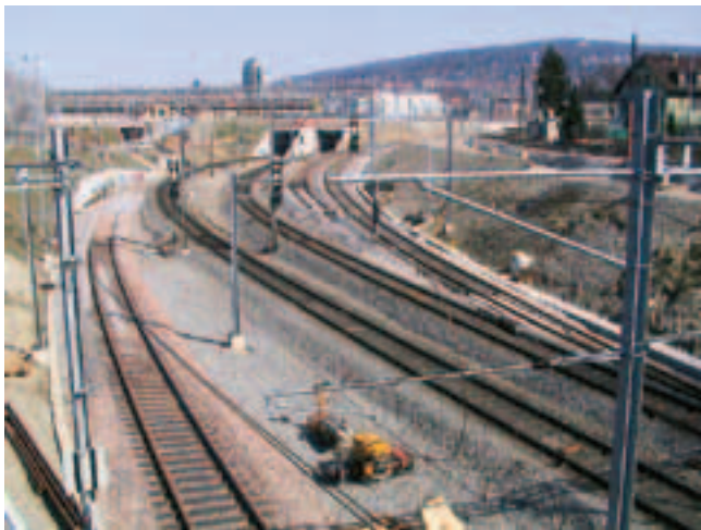
Рис. 1. Портал тоннеля со стороны станции Цюрих-Главный
