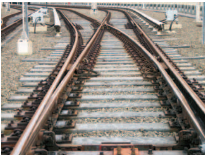
Рис. 3. Стрелочный перевод на композитных брусев компании TieTek
