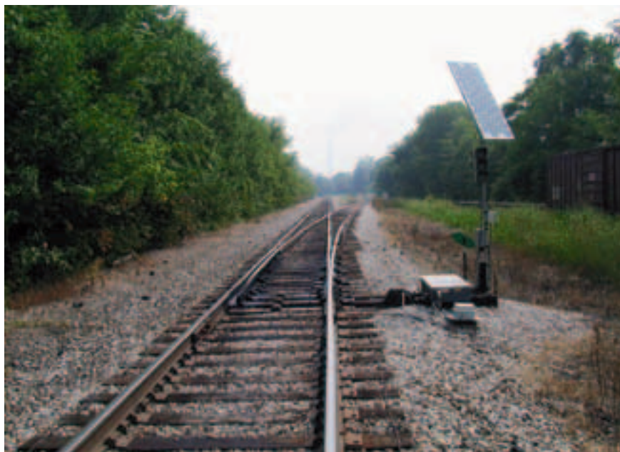
Рис. 1. Стрелочный перевод на деревянных брусках корпорации Burke-Parsons-Bowlby
