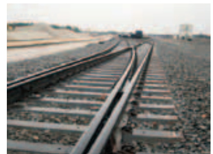
Рис. 2. Стрелочный перевод на стальных брусьях корпорации North America Railway Steel Tie
