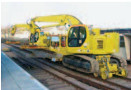
Машинный комплекс типа RCB800 на укладке рельсошпальной решетки
