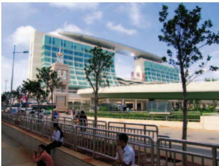
Рис. 1. Вокзал станции Куньмин железных дорог Китая, одного из конечных пунктов железнодорожной сети Юго-Восточной Азии
