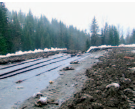
Рис. 3. Затопленные пути на подходе к тоннелю Стампид (фото: BNSF)
