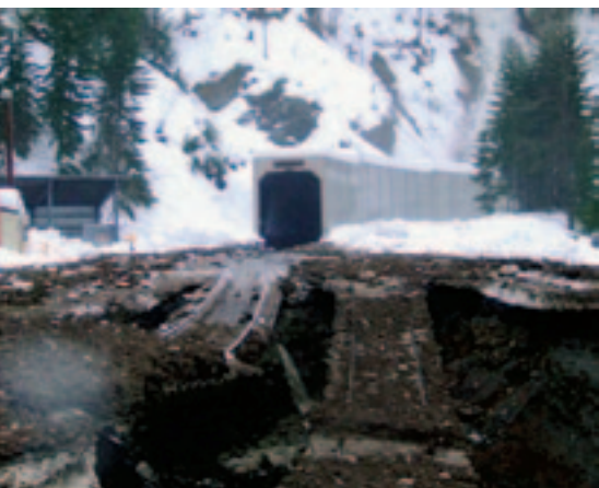
Рис. 1. Провал вблизи тоннеля Стампид (фото: BNSF)
