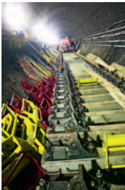
Рис. 3. Путевые работы в тоннеле линии Waterloo & City (фото: Metronet)
