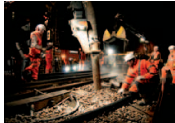
Рис. 2. Работы с вакуумным очистителем балласта компании Disab (фото: Tube Lines)
