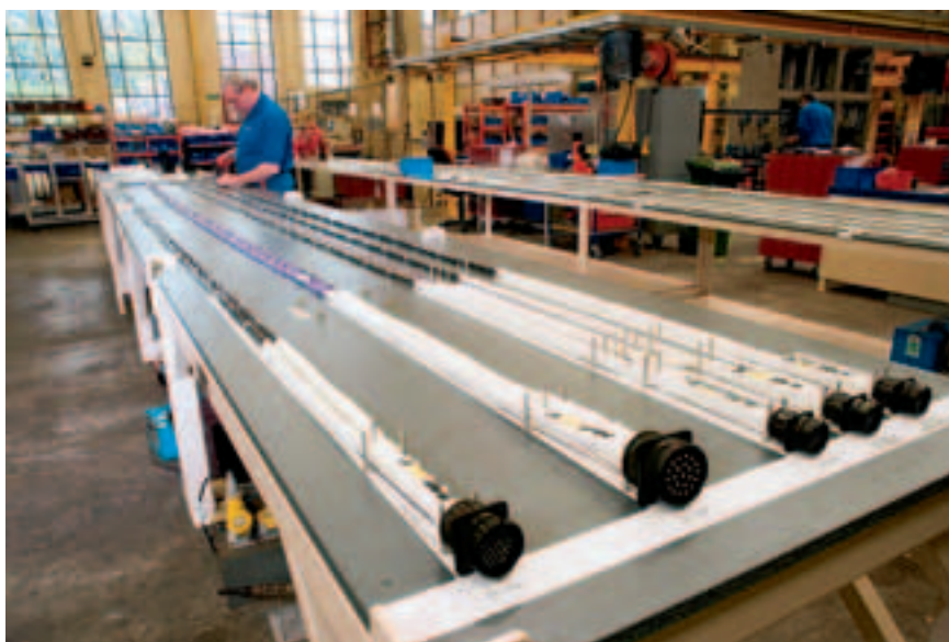
Рис. 3. Заготовка жгутов электропроводки (фото: Alstom)
