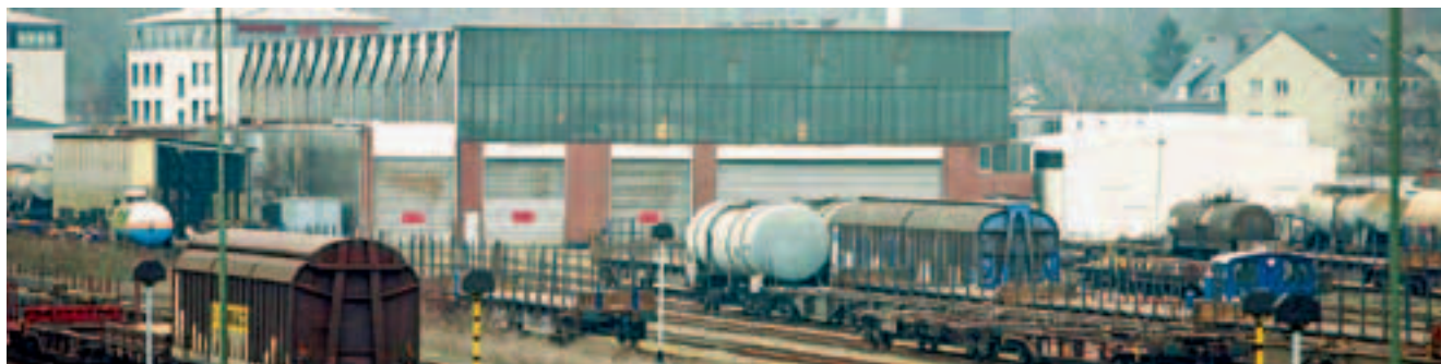
Рис. 2. Предприятие группы RSM по ремонту подвижного состава в Дуйсбурге (источник: RSM)
