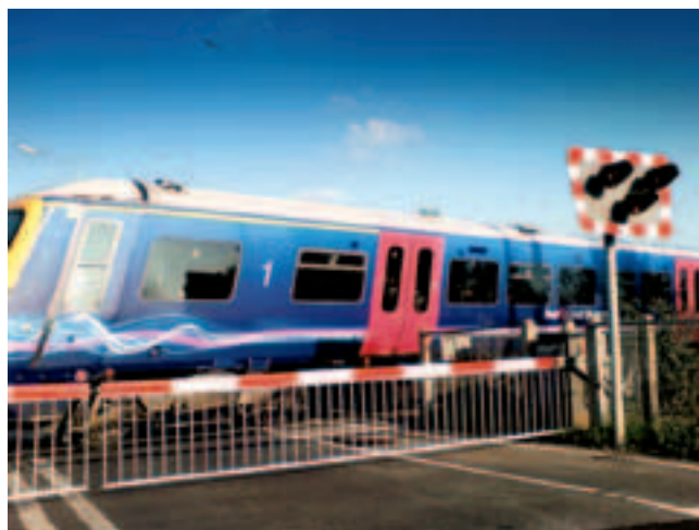
Рис. 3. Типичный железнодорожный переезд в Великобритании с автоматическими полушлагбаумами и световой сигнализацией
