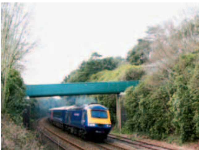
Рис. 2. Пешеходный мост модульной конструкции вблизи станции Сент-Остелл
