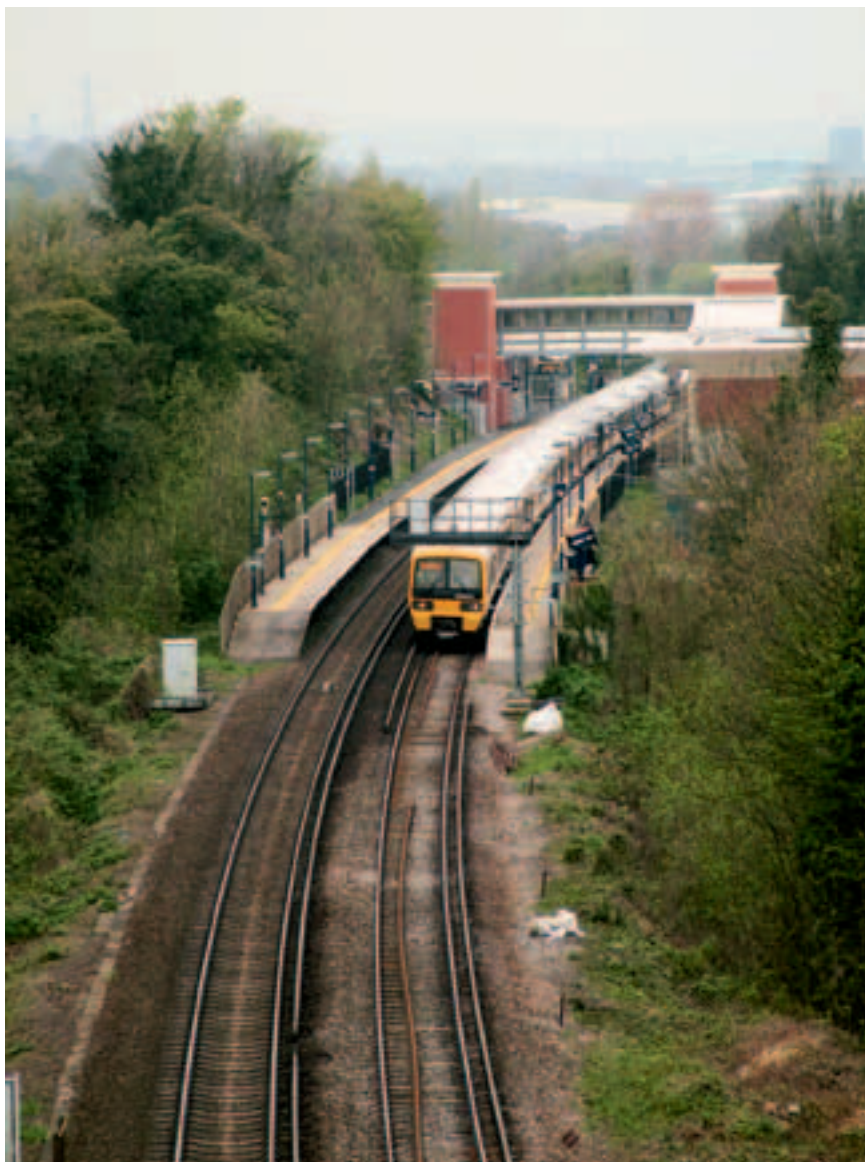
Рис. 1. Общий вид станции Гринхайт после реконструкции
