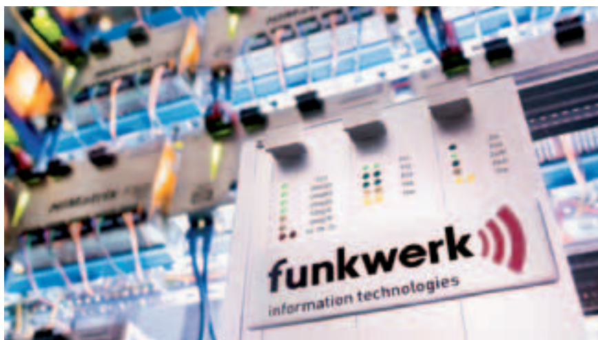
Рис. 7. Ядро МПЦ Alister 2.0 с безопасными программируемыми контроллерами
