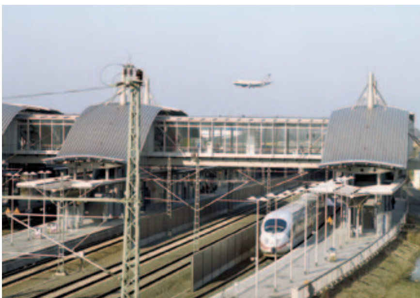
Рис. 1. Железнодорожная станция в аэропорту Дюссельдорфа
